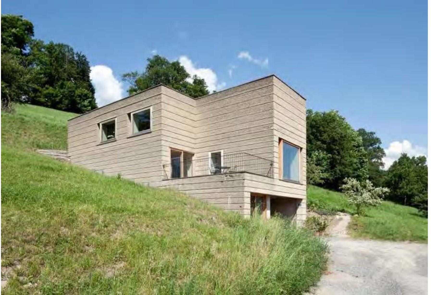
HAUS RAUCH, Österreich | Arch. Roger Boltshauser, Martin Rauch
